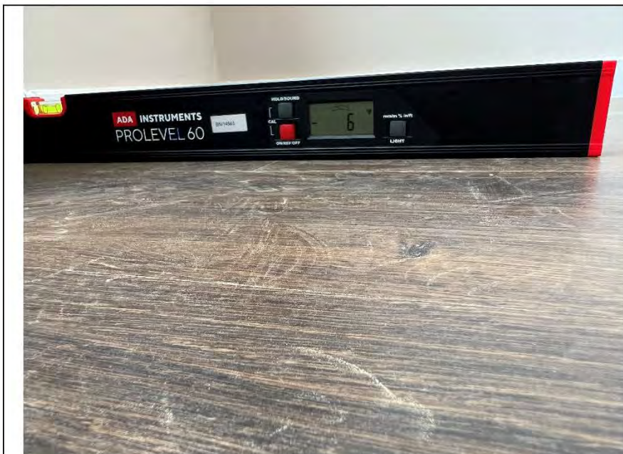
Фото №22. Измерение уровня напольного покрытия в гостиной.
