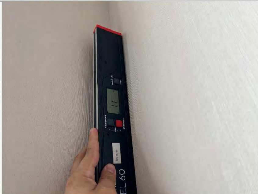
Фото №11. Измерение уровня стен в гостиной.
