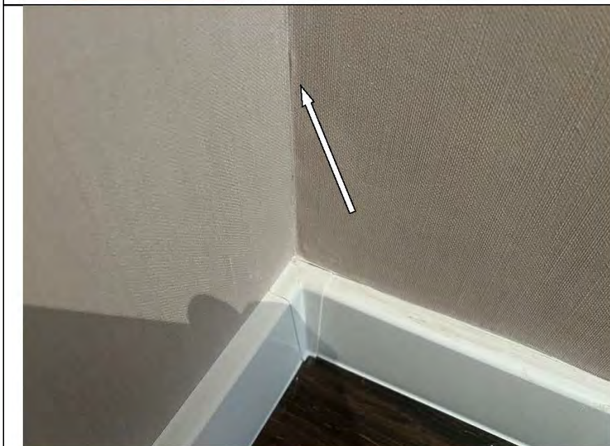
Фото №14. Читаемые обойные стыки в коридоре.
