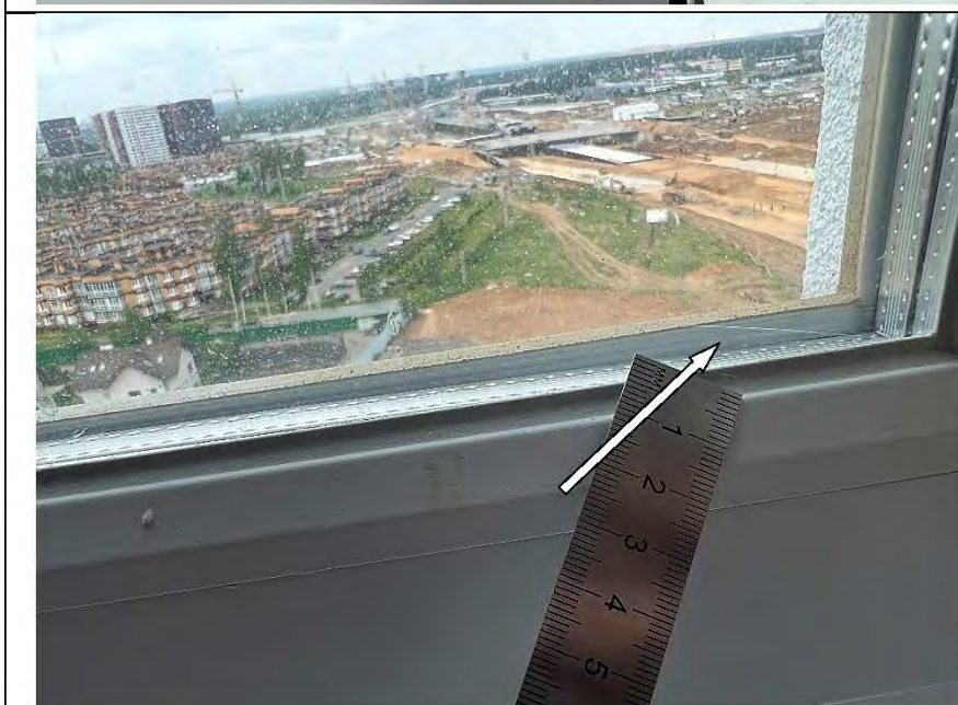
Фото №30. Царапина на стеклопакете оконного блока ПВХ в гостиной.
