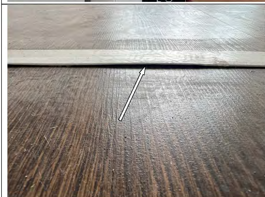
Фото №51. Щель в между металлическим порожком и ламинатом в гостиной.
