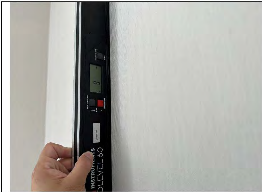
Фото №13. Измерение уровня стен в кухне.
