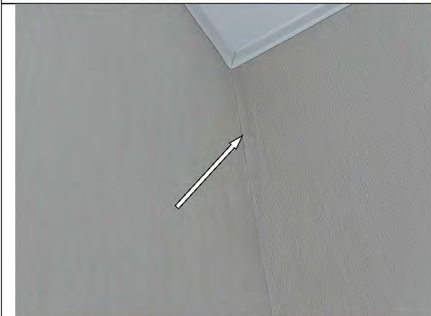
Фото №17. Читаемые обойные стыки в кухне.
